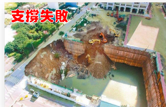
深開挖災變常見之破壞類型
